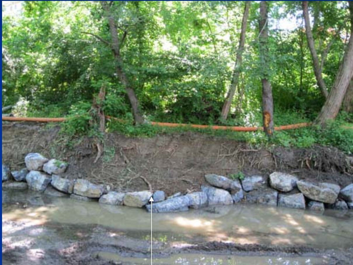
Toe Rip Rap
